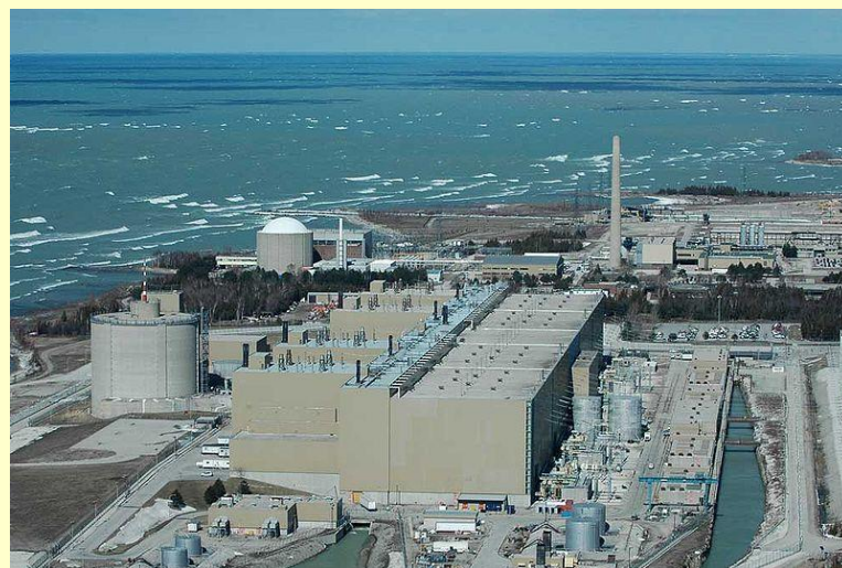
Kanadská elektrárna Bruce B
