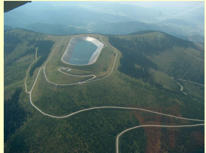
Přečerpávací elektrárna Dlouhé Stráně: 650 MW, 3900 MWh (zdroj ČEZ)
